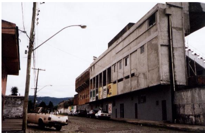
Figura 21 – Vista à Oeste Sudoeste na Rua Ana Nery, frente do Estádio (parte reformada).
