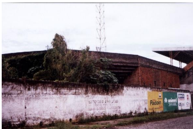
Figura 20 – Vista à Oeste Sudoeste na Rua Ana Ney, fundos do Pavilhão B.
