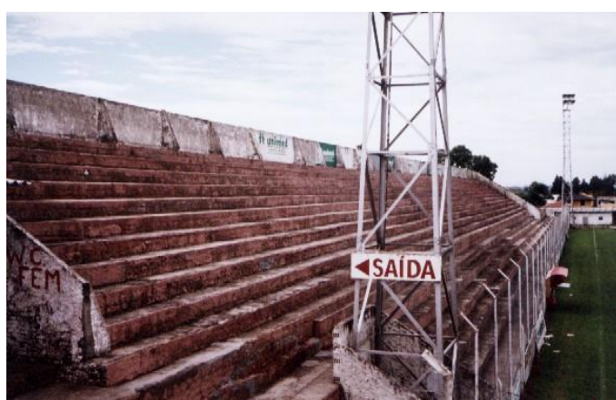
Figura 14 – Arquibancada denominada Geral
