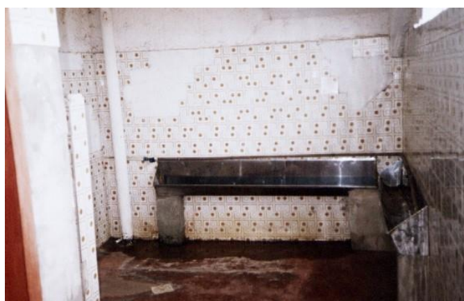
Figura 17 – Banheiro das cadeiras numeradas (vista interna)
