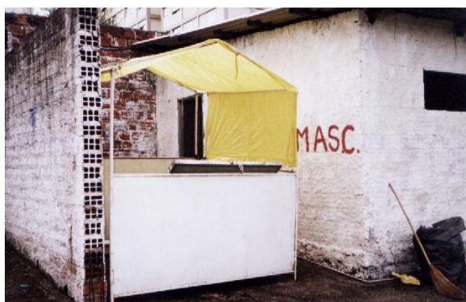
Figura 16 – Banheiro da Geral (vista externa) e barraca de alimentação/copa
